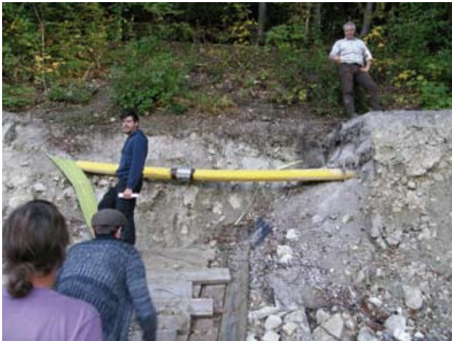
Nach der Verlegung einer Gasleitung - hier letzte Reste - setzte sich der Hang in Bewegung
